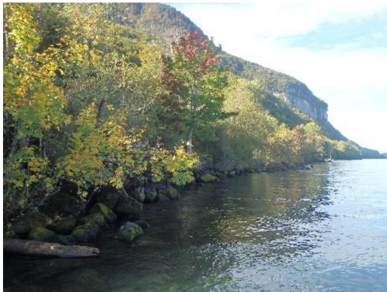
Photo 4 : Vue vers l'ouest sur les enrochements de berge
