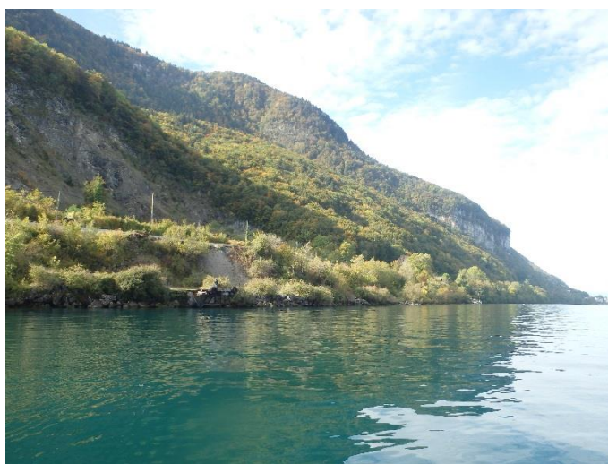
Photo 3 : Vue du site de déchargement de Locum
